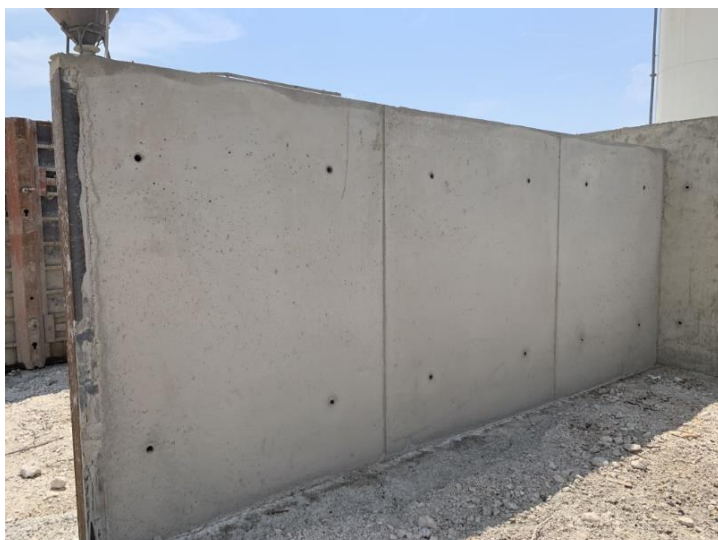
Figure 1. Voile BPE coulé sur le site de Tigneux (38)
