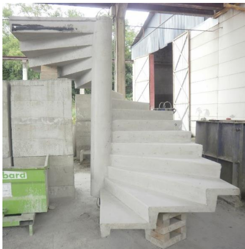
Figure 9. Escalier après démoulage
