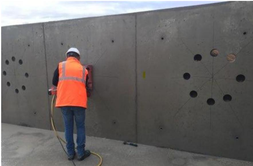
Figure 1. Photo du carottage des voiles béton
