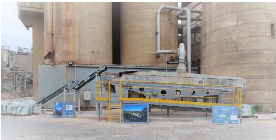
Figure 6. Démonstrateur mis en œuvre par Lafarge sur le site de Val d'Azergues. (Izoret et al (2021))
