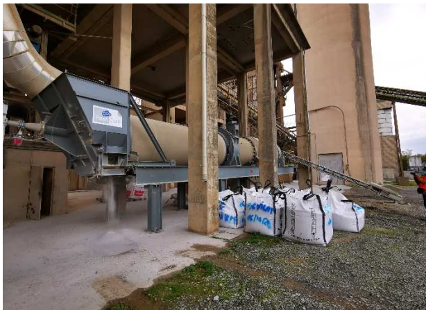
Figure 4 : Démonstrateur mis en œuvre sur le site de Créchy par VICAT.
