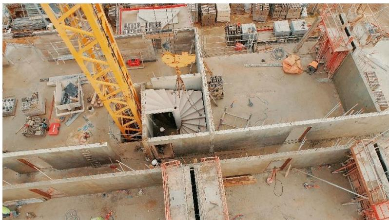
Figure 35. Pose de l'escalier sur chantier
