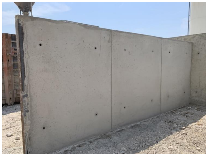
Figure 31 Voile BPE coulé sur le site de Tigneux (38)
